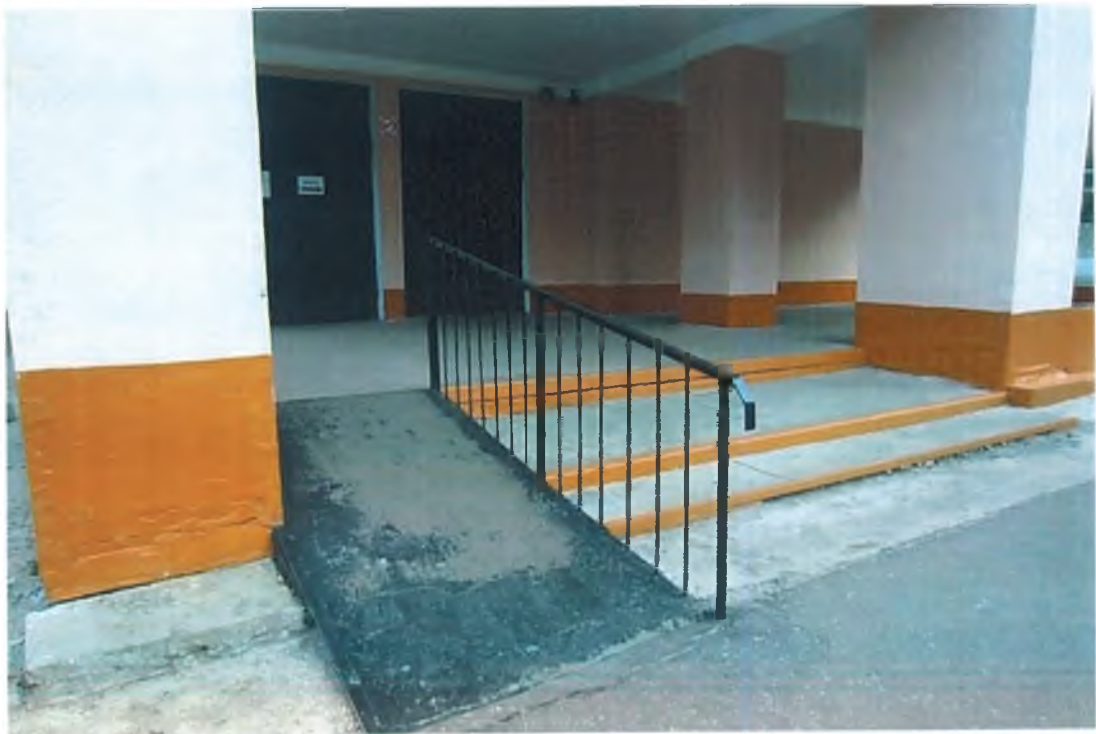
Лестница (наружная) и пандус (наружный), фото №1
