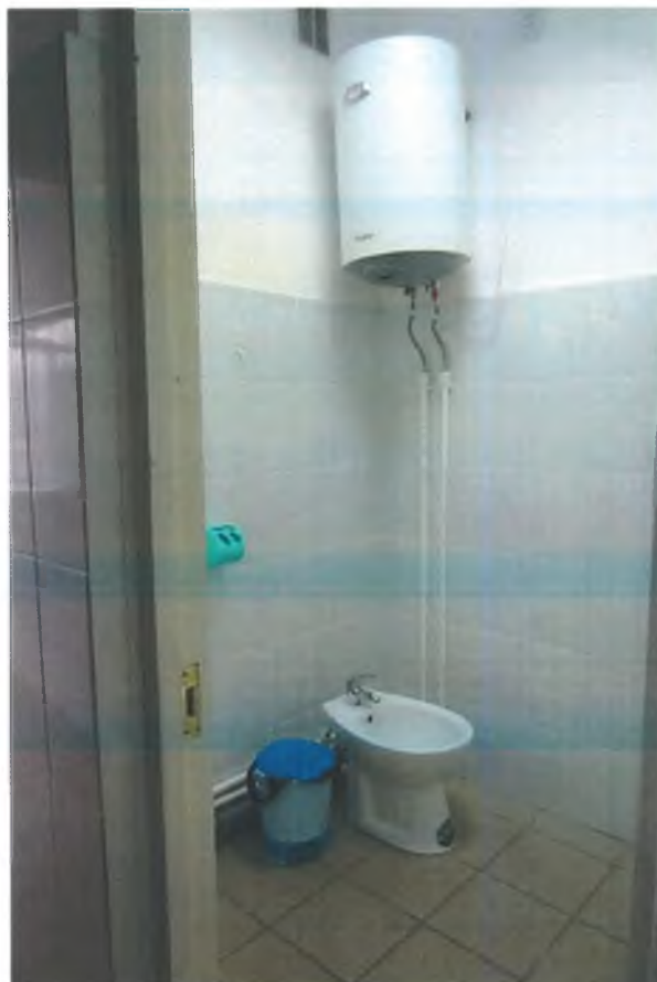
Туалетная комната, фото №2
