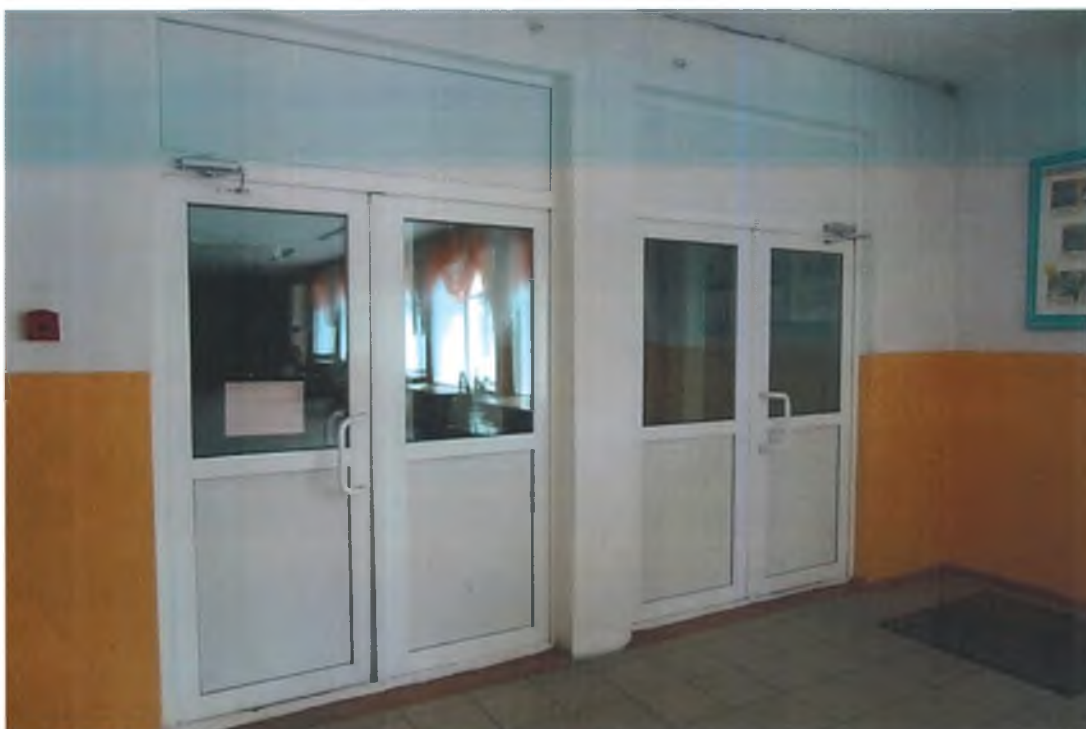
Пути эвакуации, фото №4
