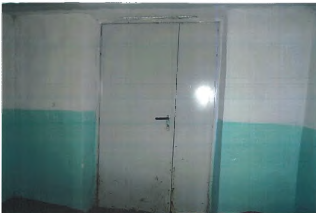
Пути эвакуации, фото №5
