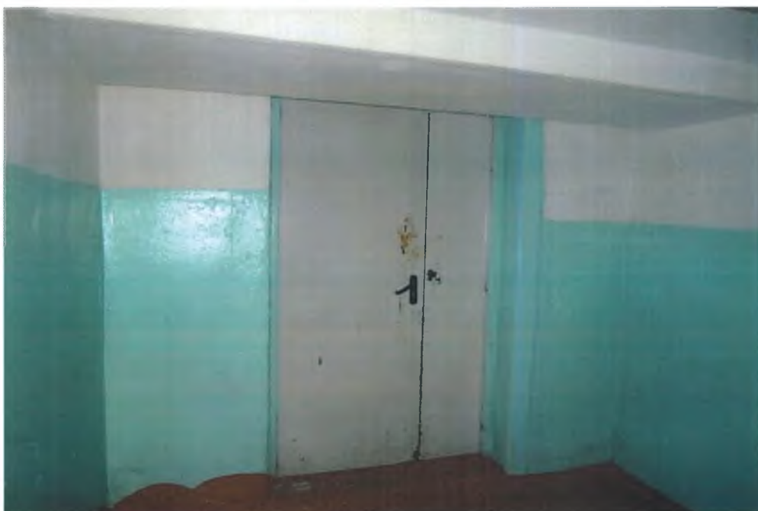
Пути эвакуации, фото №6
