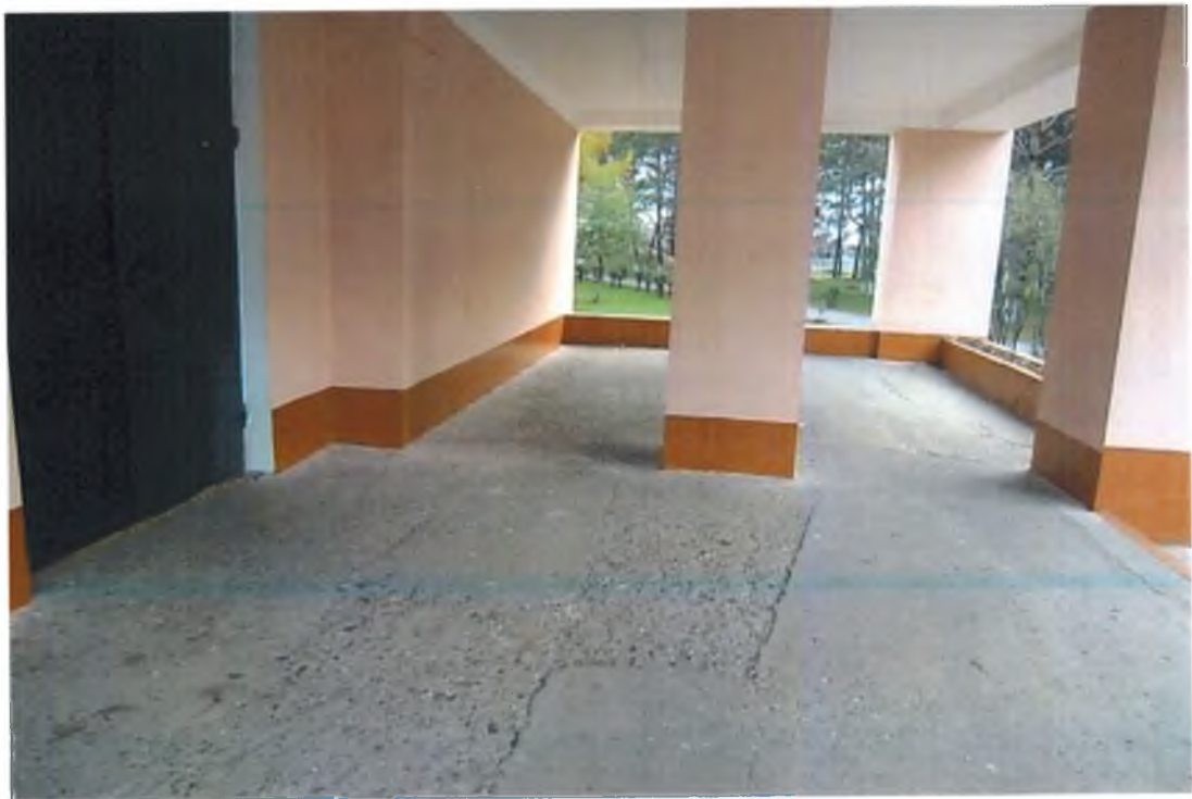
Входная площадка (перед дверью), фото №1
