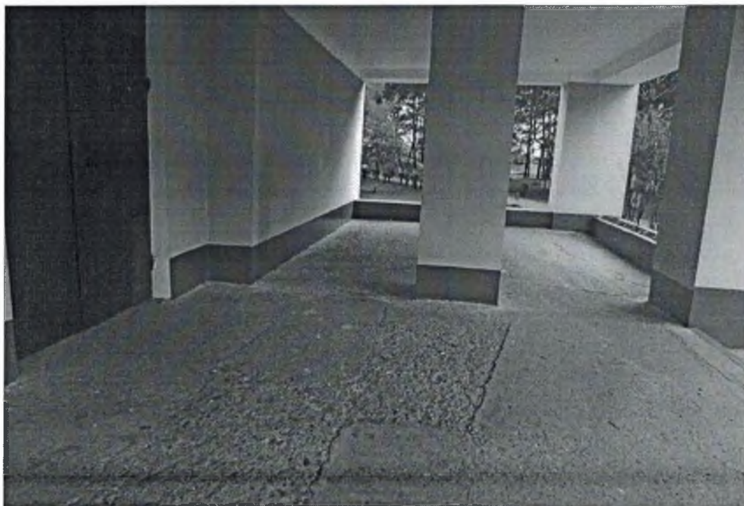
Входная площадка (перед дверью), фото №6
