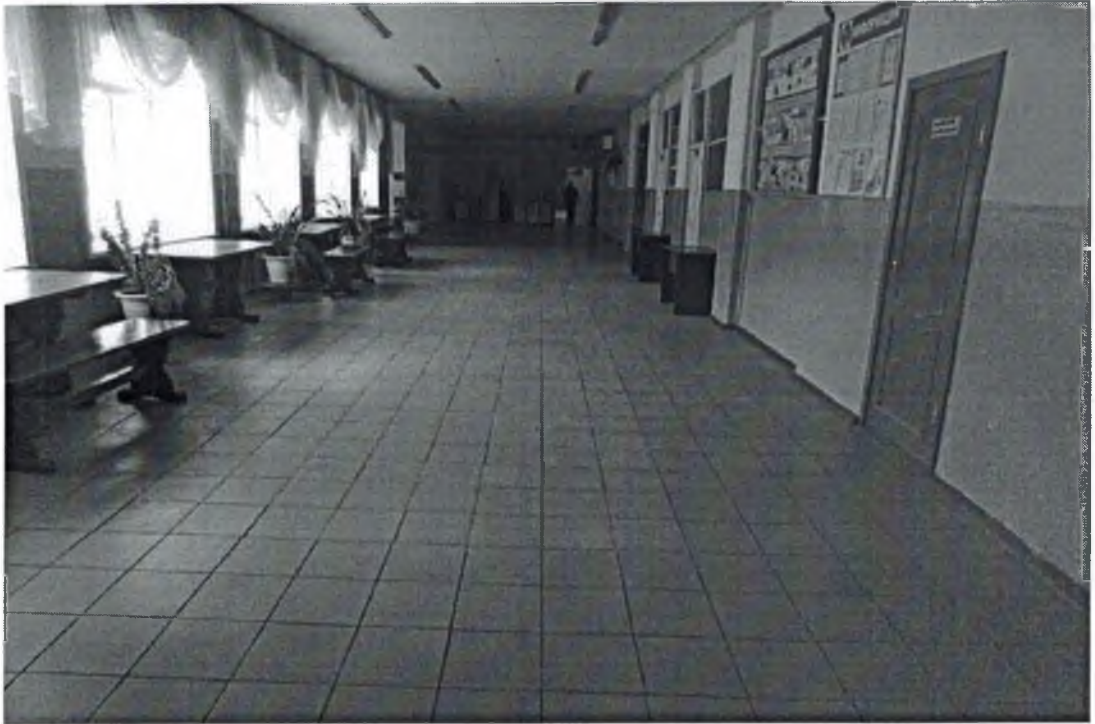
Коридор 1 этажа 1, фото №9
