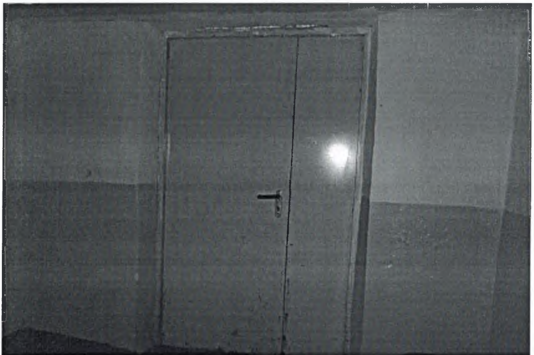
Пути эвакуации, фото №14
