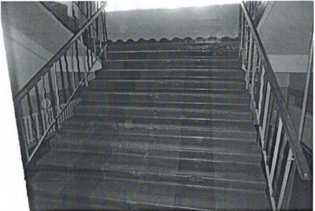
Лестница (внутри здания), фото №10
