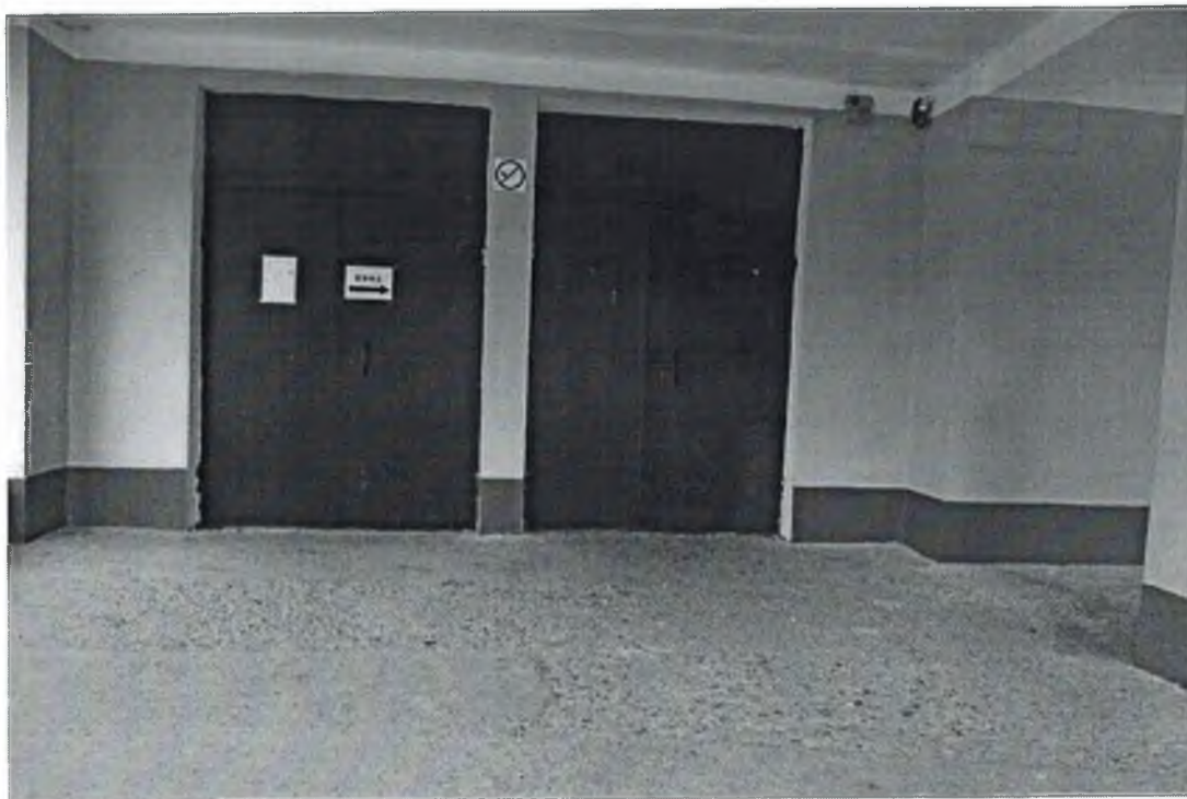
Дверь (входная), фото №7
