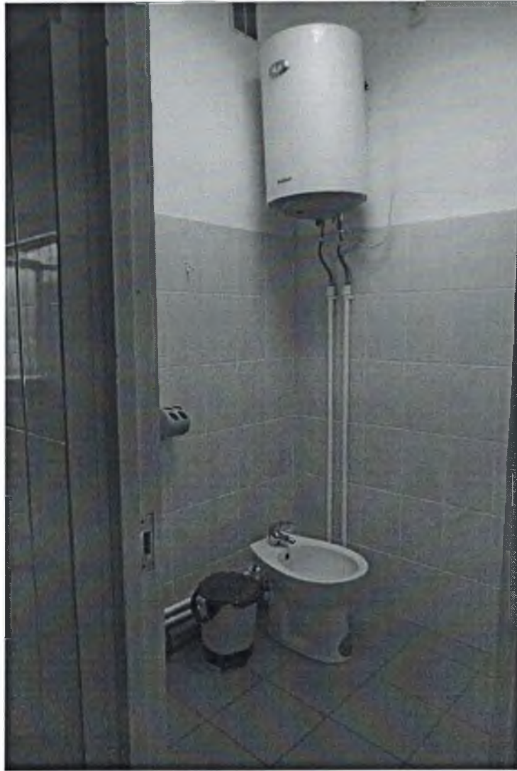
Туалетная комната, фото №17
