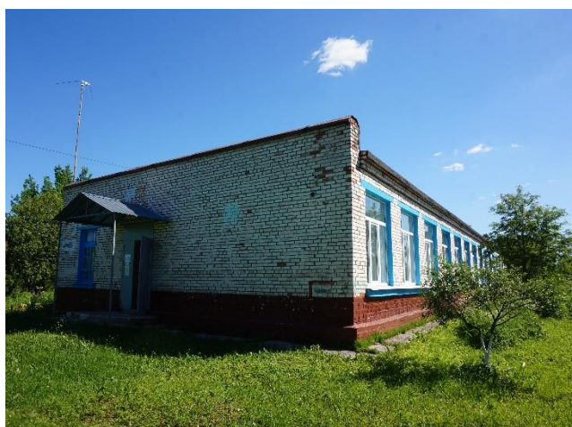
Ф.1.3. Общий вид здания
