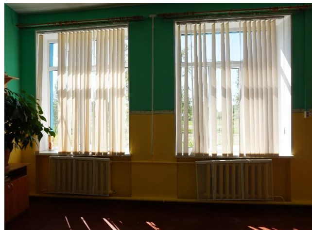
Ф.1.12. Общий вид системы отопления
