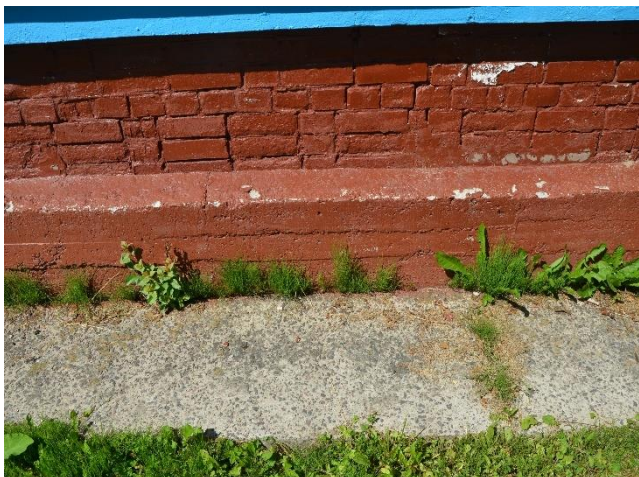
Ф.1.25. Волосяные трещины в фундаменте, разрушение отмостки
