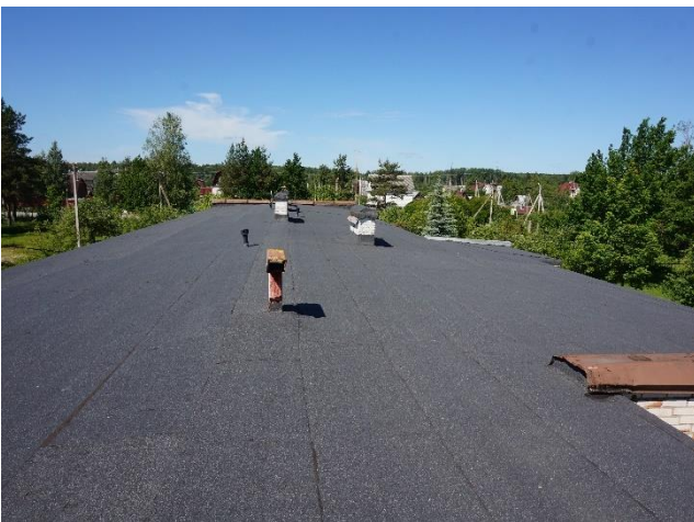
Ф.1.9. Общий вид кровли
