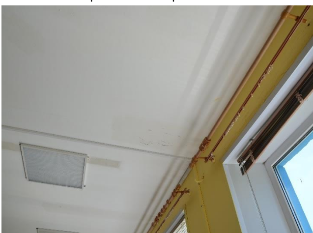
Ф.1.15. Разрушение отделочного слоя по стыку плит покрытия
