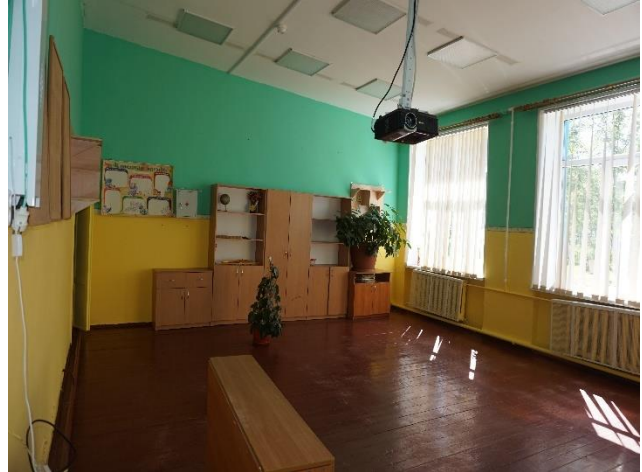
Ф.1.8. Общий вид внутренних помещений
