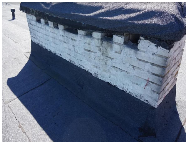
Ф.1.14. Общий вид вентиляционного блока
