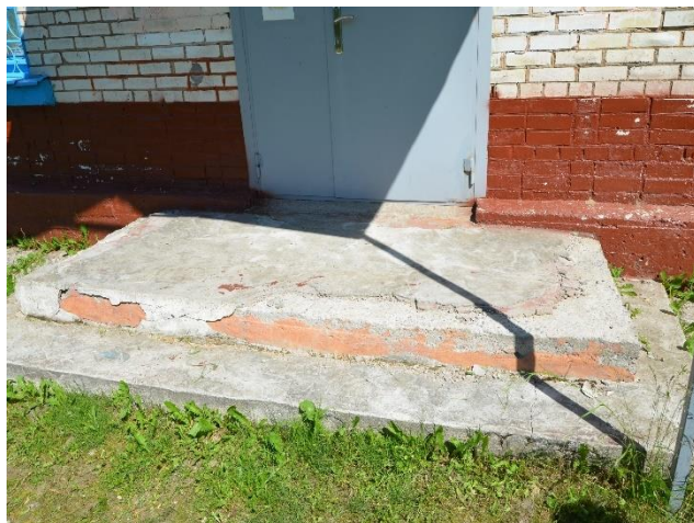
Ф.1.26. Разрушение ступеней бетонных лестниц
