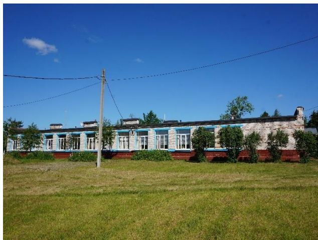
Ф.1.2. Общий вид здания
