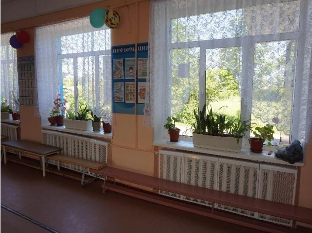
Ф.1.7. Общий вид внутренних помещений
