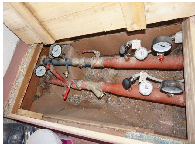
Ф.1.10. Общий вид ИТП
