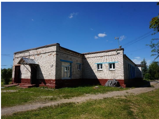
Ф.1.1. Общий вид здания
