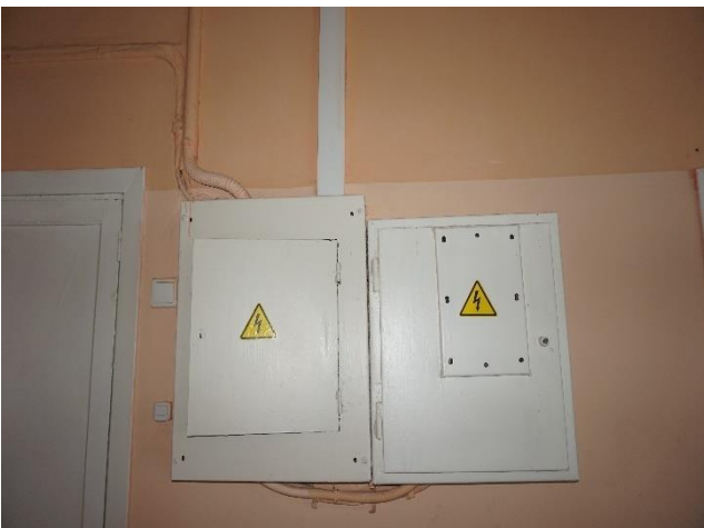
Ф.1.11. Общий вид электросчетовой
