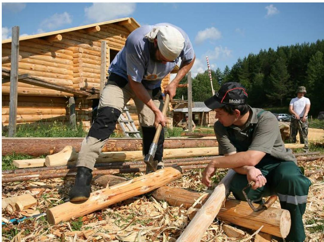
Плотник обрабатывает дерево. Он пилит, строгает, рубит топором деревянные брусья. Плотник изготавливает деревянные предметы: табуретки, двери, окна, крыши домов, полы, стены, потолки.
