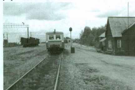
Главное здание станции Ерцево
