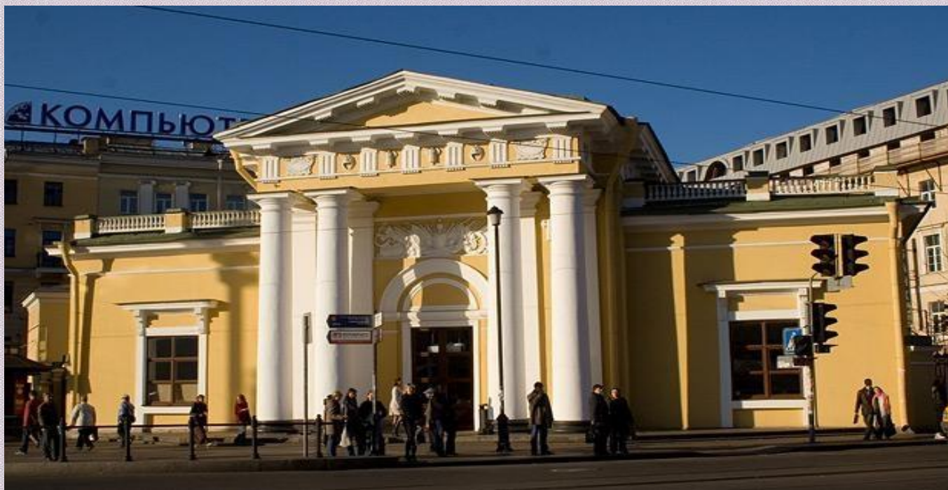
Садовая,37. Бывшая гауптвахта на Сенной площади.
